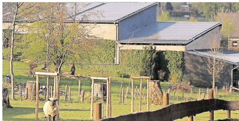
180 Solarpanels sind auf dem Dach über den ehemaligen Stallungen in Monschau-Rohren montiert worden.
